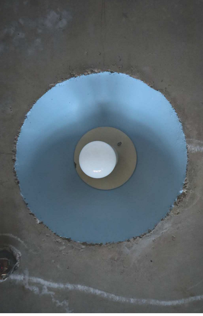
Välipohjiin on tehty upotuksia, joihin on asennettu lamppuja. Nykyiset led-polttimot eivät vastaa alkuperäistä tavoitetta, jossa polttimon valinnalla on ollut keskeinen rooli.
